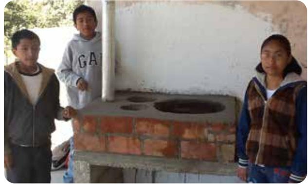
Bau des Sockels für Ofen und Biogasanlage aus Ziegeln und Zement
